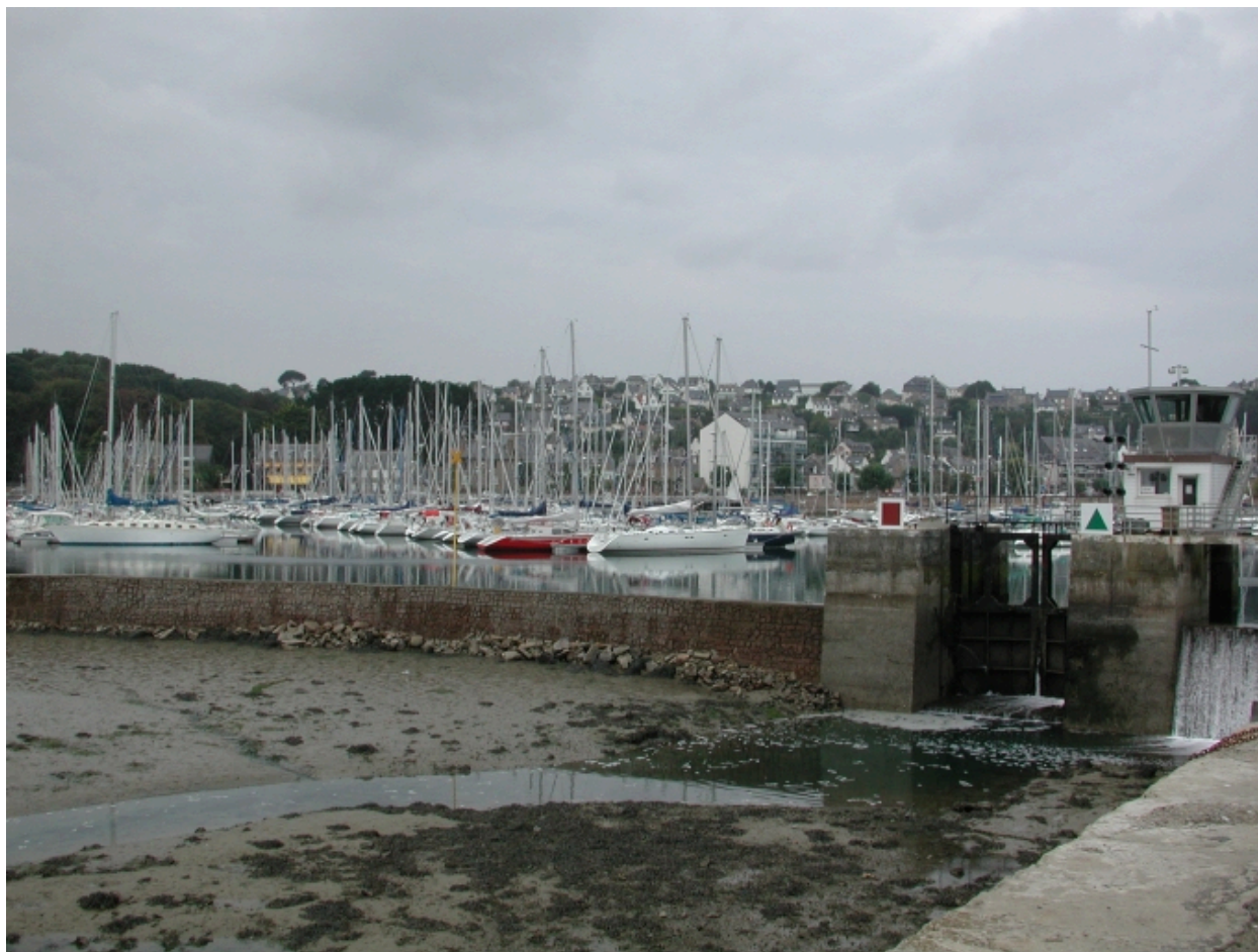
Le bassin à flot et la porte
