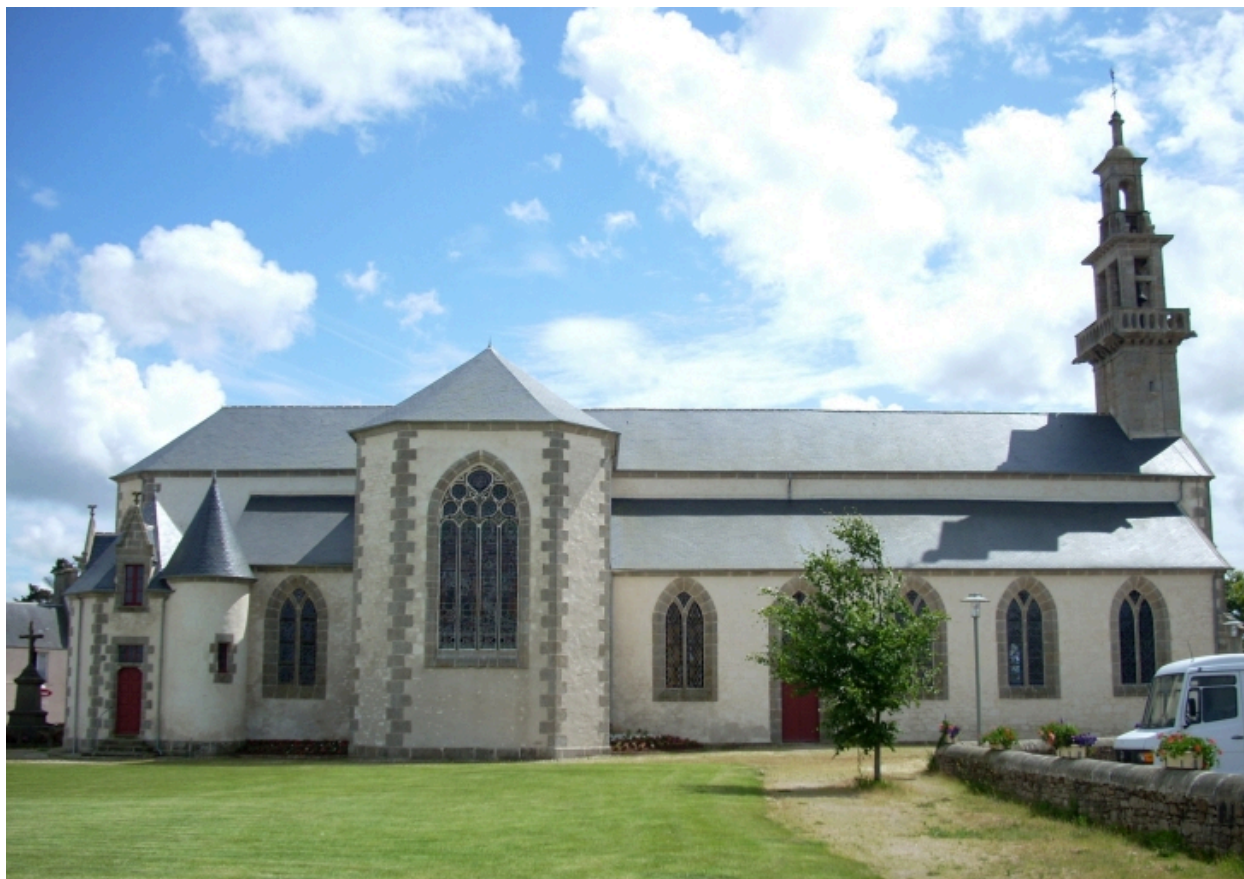
Plouvien, église paroissiale : élévation nord
