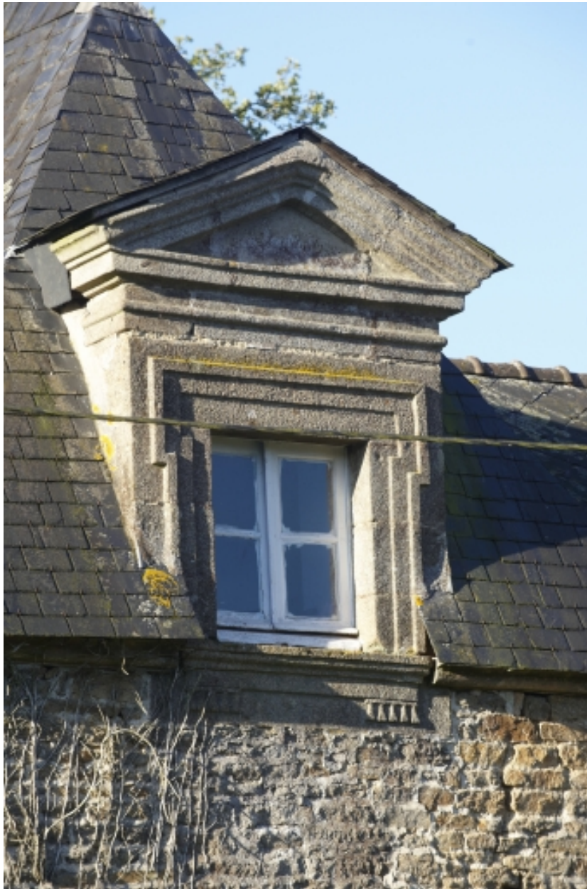
Détail de l'une des lucarnes des communs
