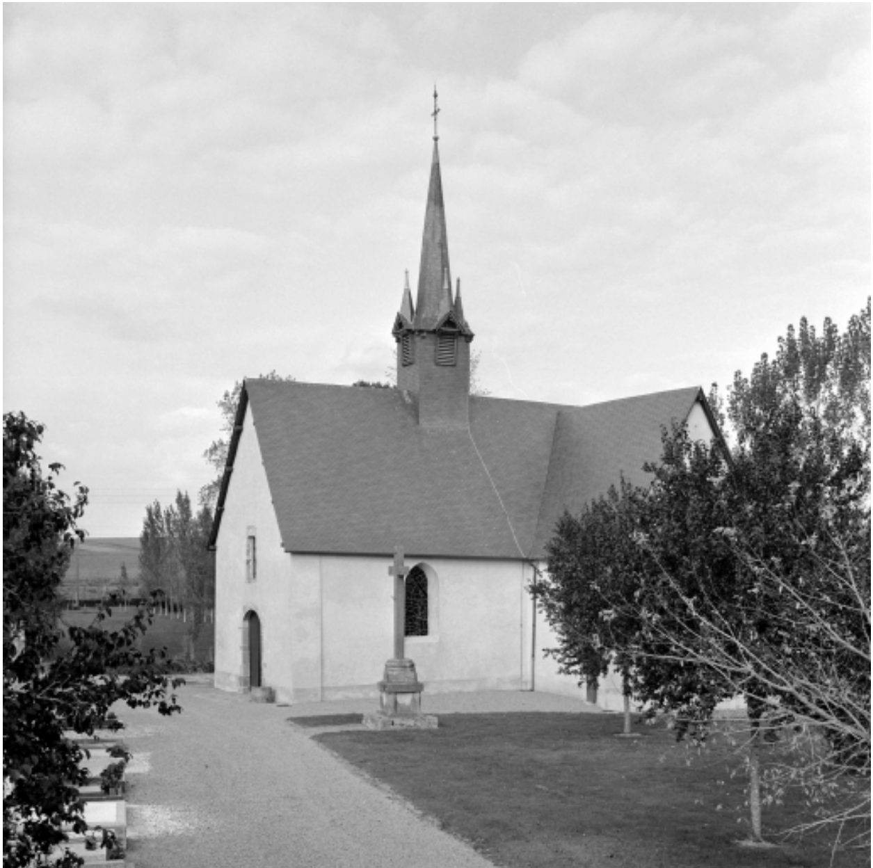
Elévation Sud-Ouest : vue générale
