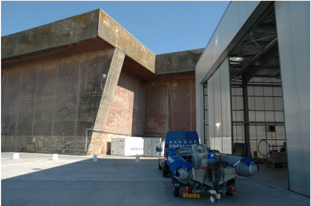
Vue de l'élévation ouest située derrière les docks : contrefort et dalle de couverture (2005)
