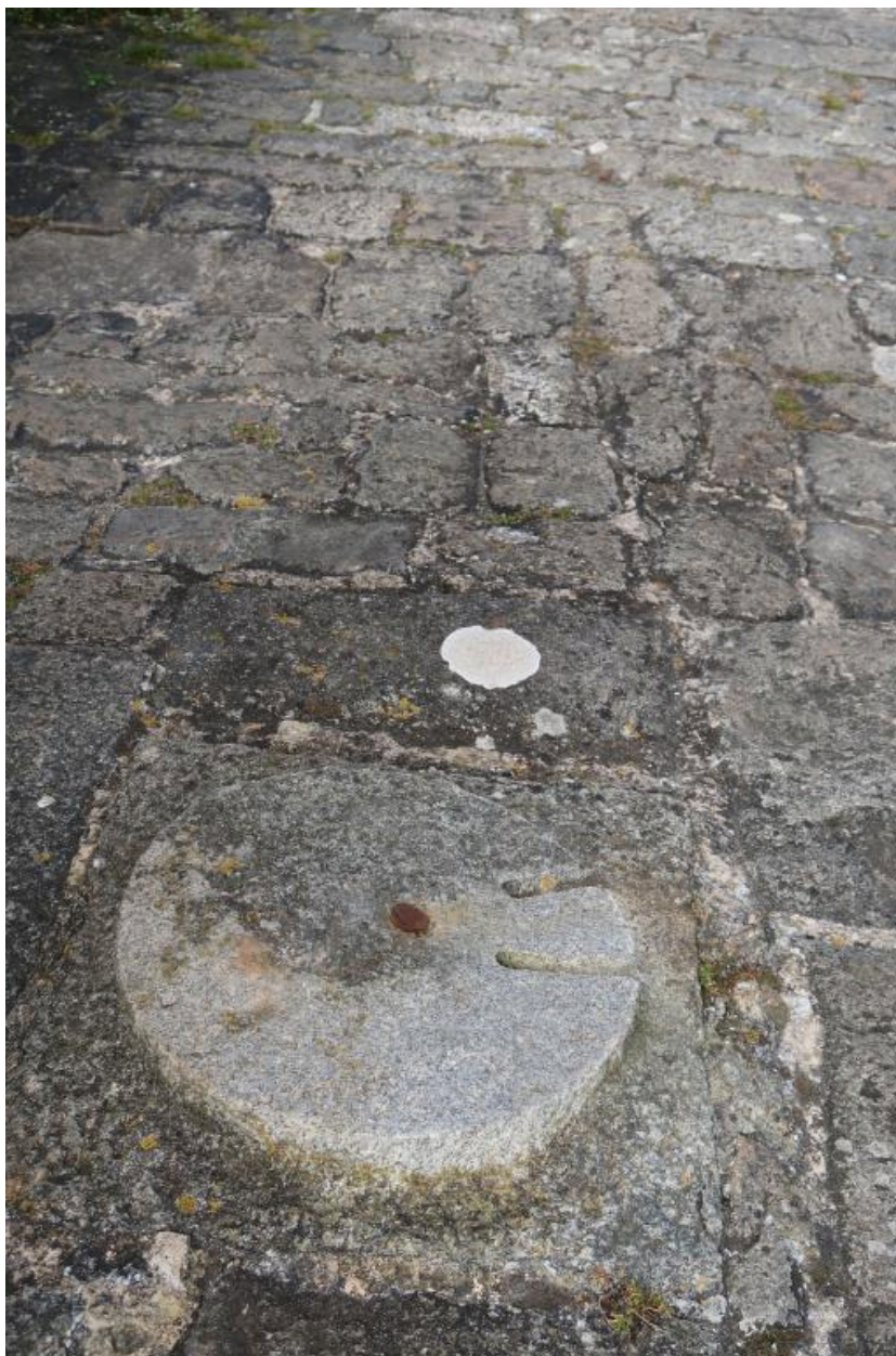
Trace de bitte d'amarage arasée lors des travaux réalisés au cours du 20e siècle
