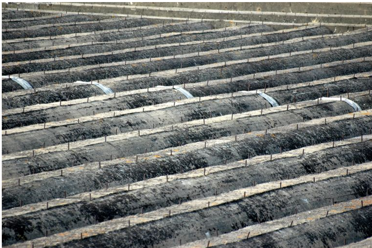
Vue de détail de la structure de type Fangrost
