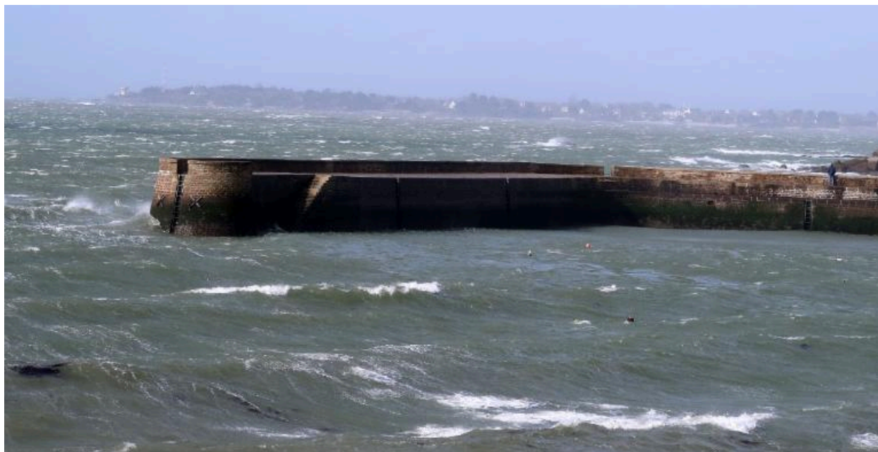
Môle de la Croix, musoir, escaliers, côté nord
