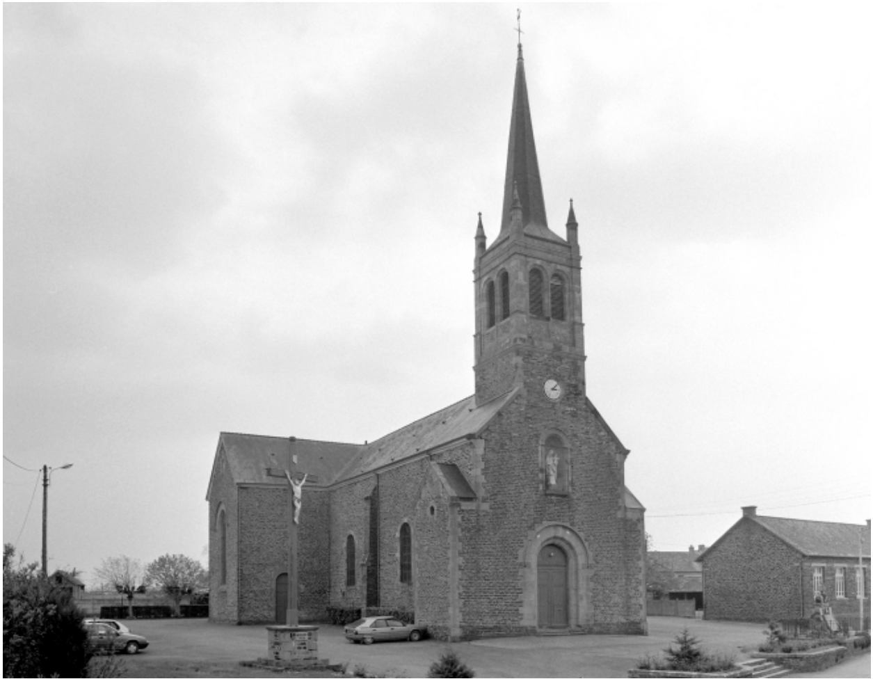
Elévation Nord-Est : vue générale
