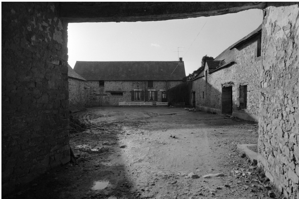
Cour intérieure, vue vers l'ouest.
