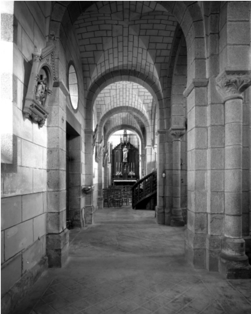
Saint-Ségal, église paroissiale Saint-Séverin : intérieur, bas-côté nord, état en 1972
