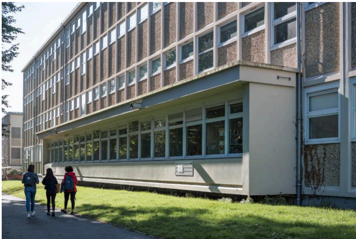
Bâtiment E, façade est : détail sur l'encorbellement du CDI (à l'origine, vraisemblablement un foyer de l'internat).
