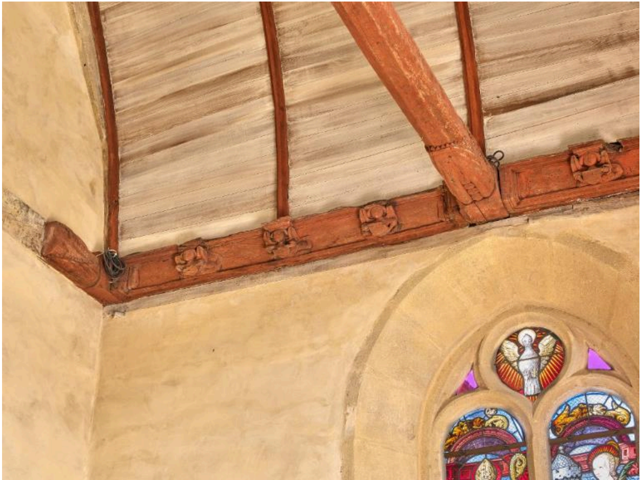
Sablière sculptée du transept sud
