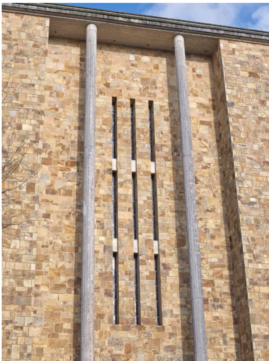
Eglise Saint-Louis, élévation nord
