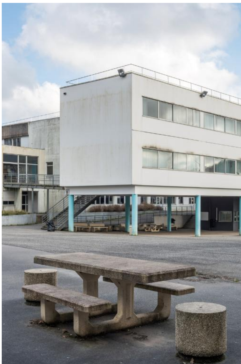
Angle nord-ouest de l'externat de 2001 (P. Ruelland et M. Quéré, architectes).
