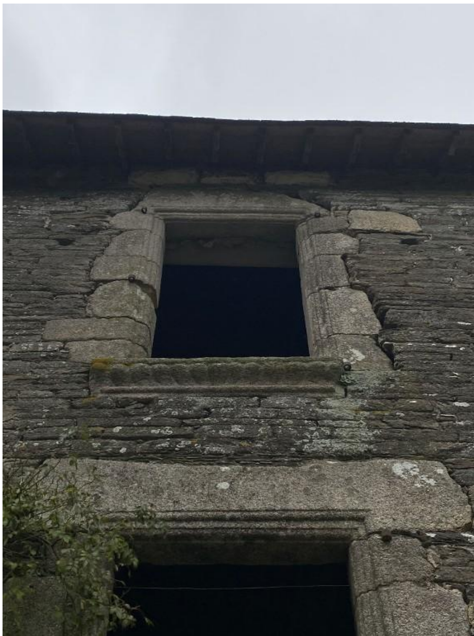
Élévation ouest, détail
