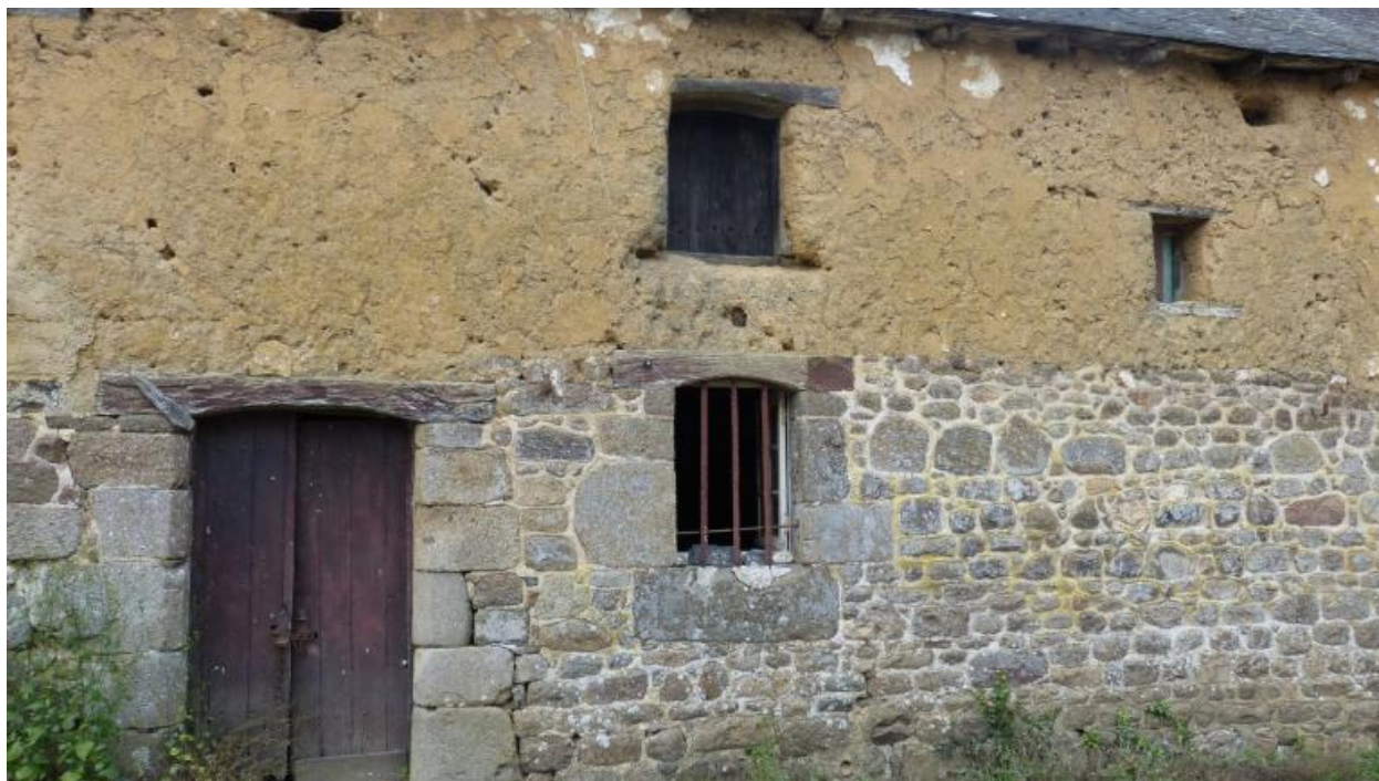
Détail de la façade est
