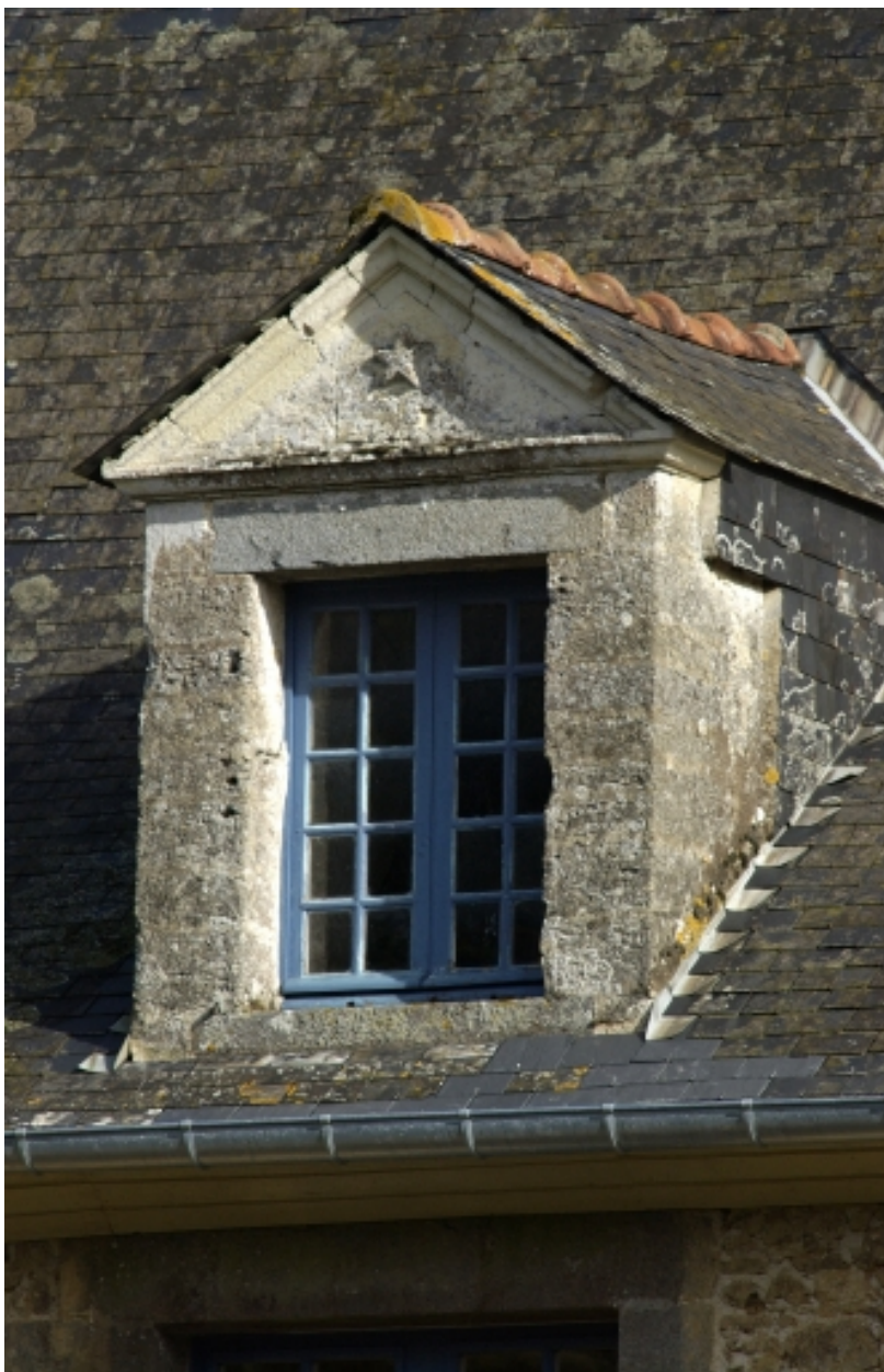
Lucarne en tufeau, façade ouest
