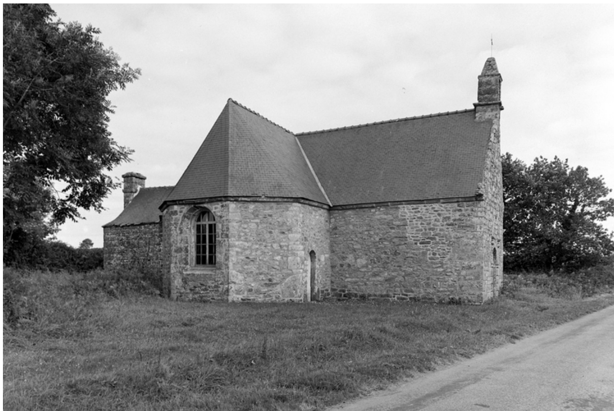
Vue de situation prise du nord ouest
