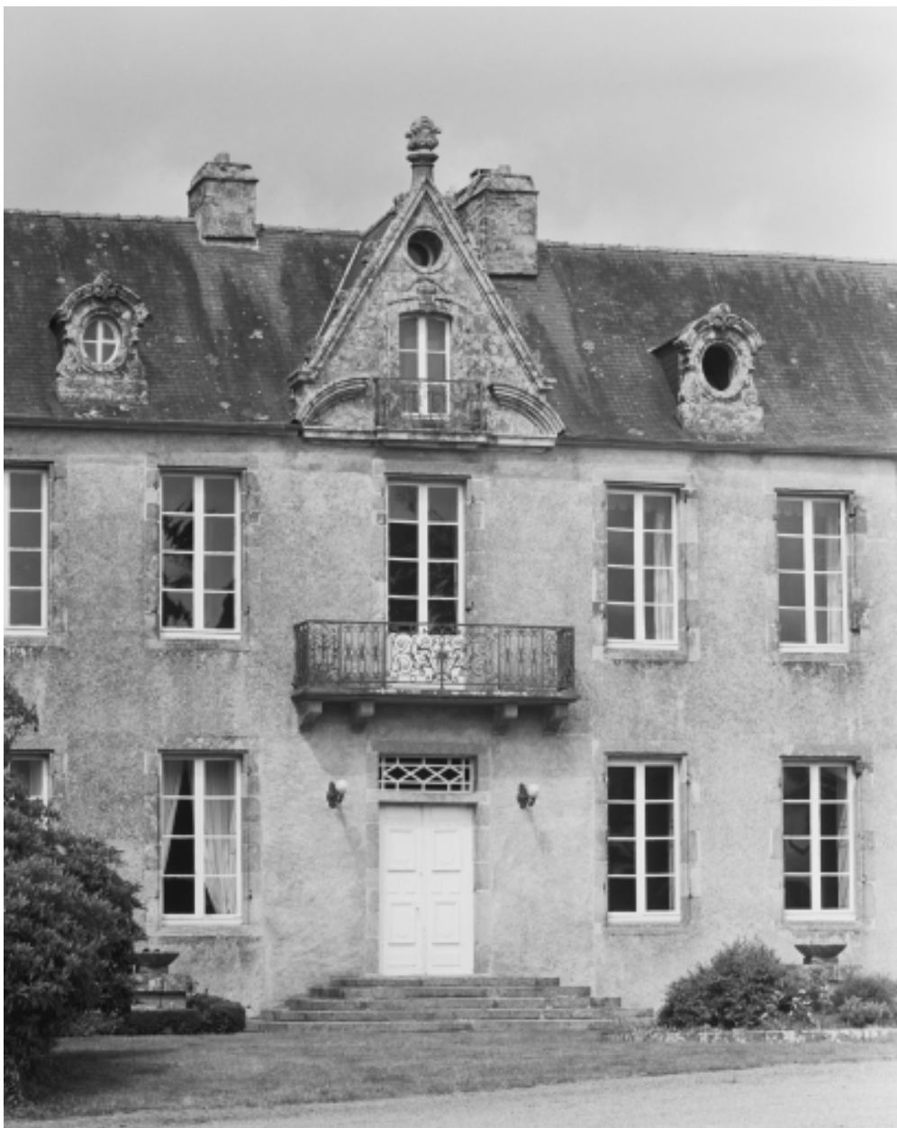
Elévation est, travée centrale
