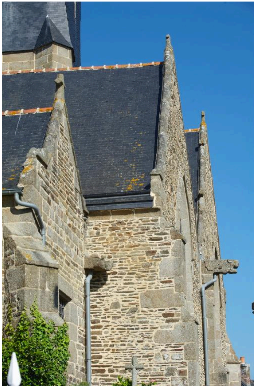
Détail de la façade nord
