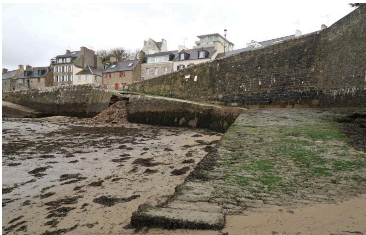
Cale ouest du Drellac'h construite en 1836
