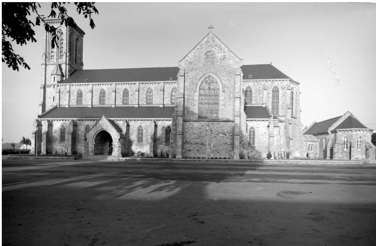
Vue générale façade sud
