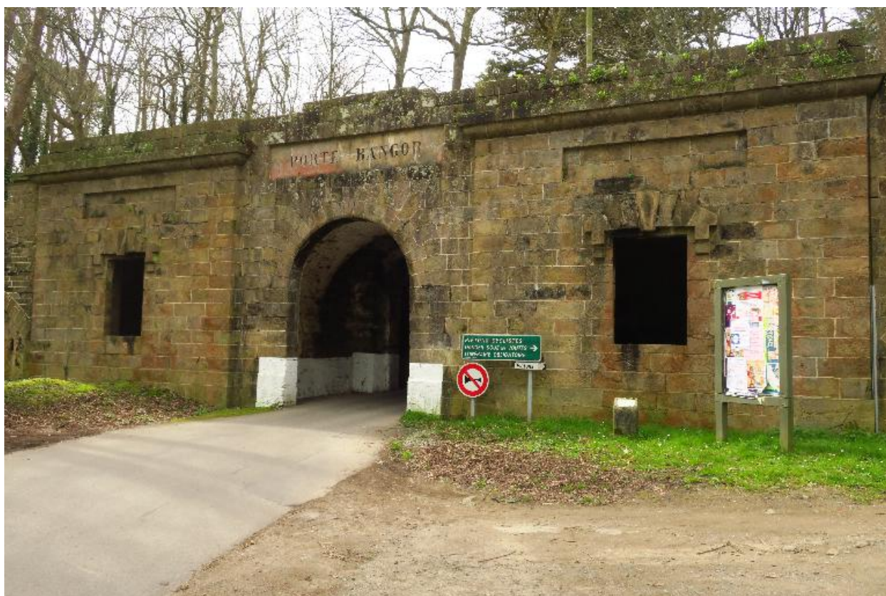
Le Palais, enceinte urbaine, porte de Bangor.
