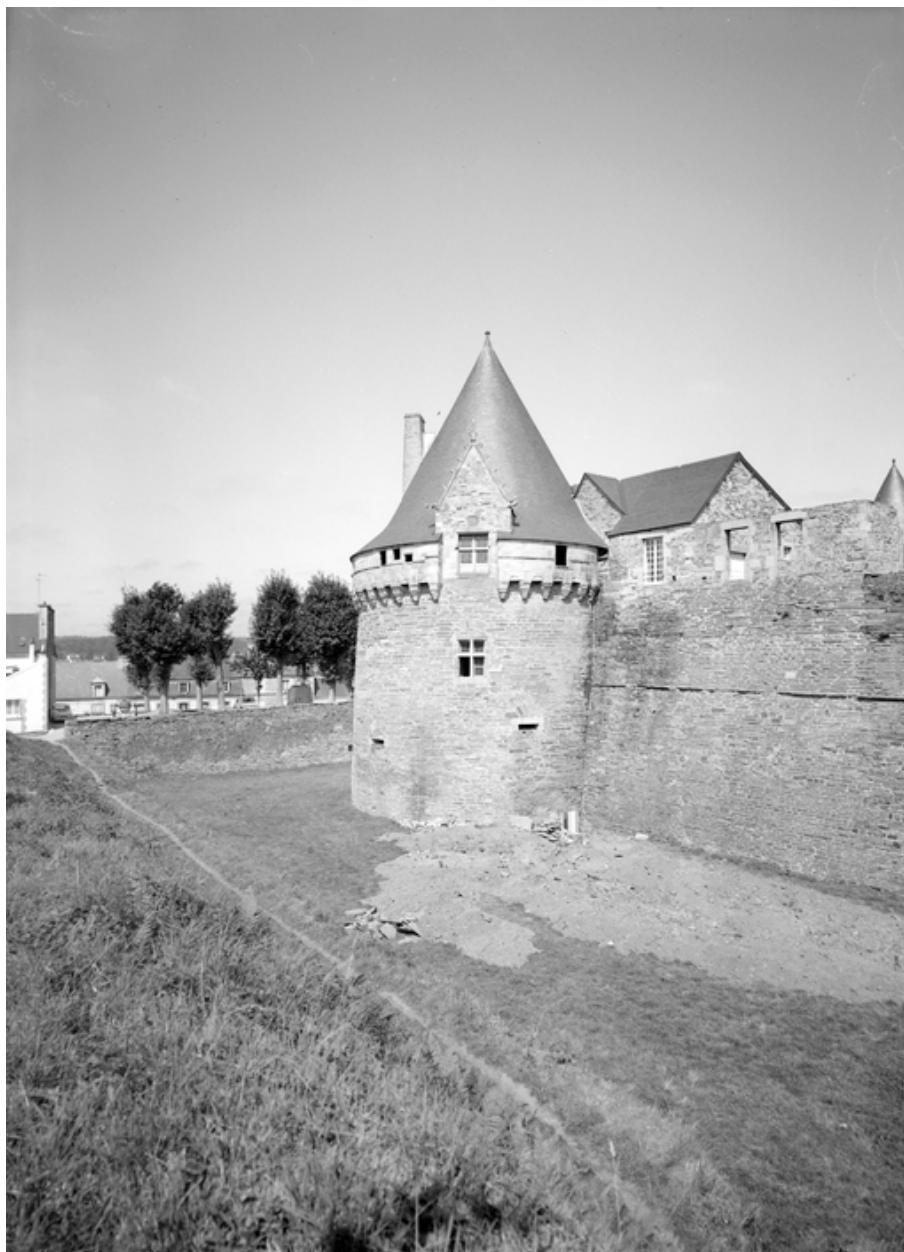
Tour sud-ouest, vue du sud-est.
