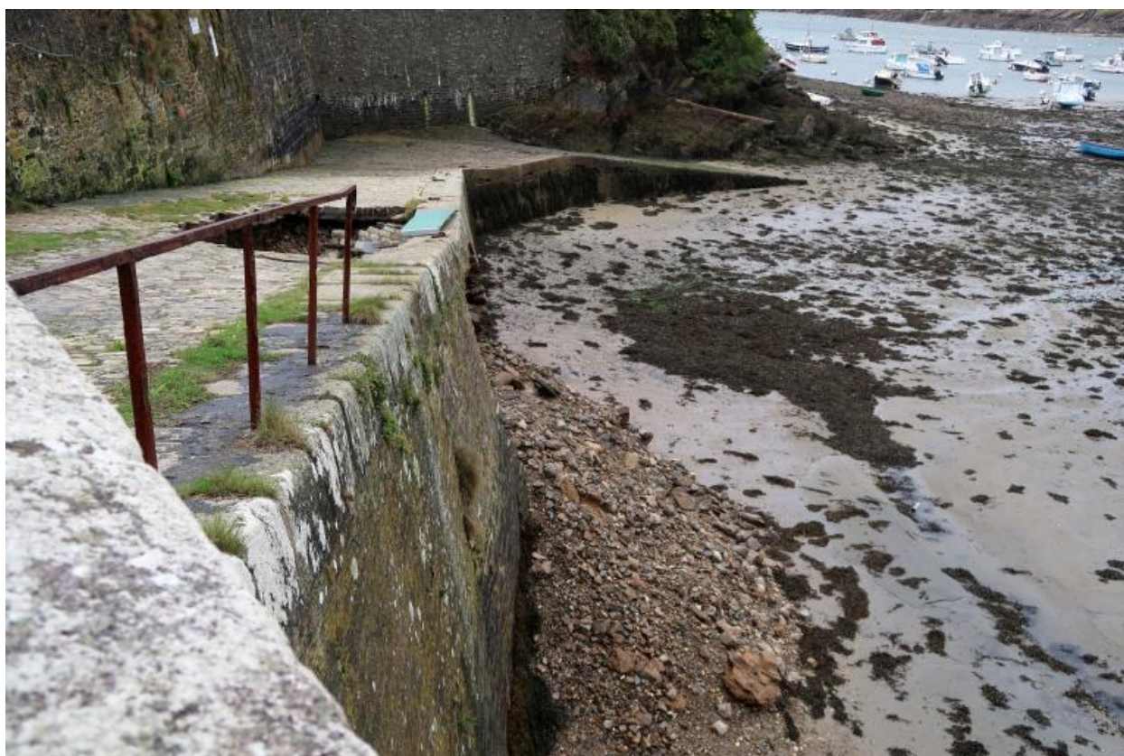
Cale Ouest, parapet et garde-corps
