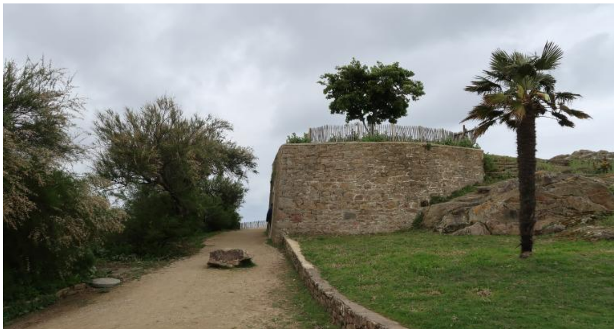
Vue générale de l'élévation Sud (état en 2023)
