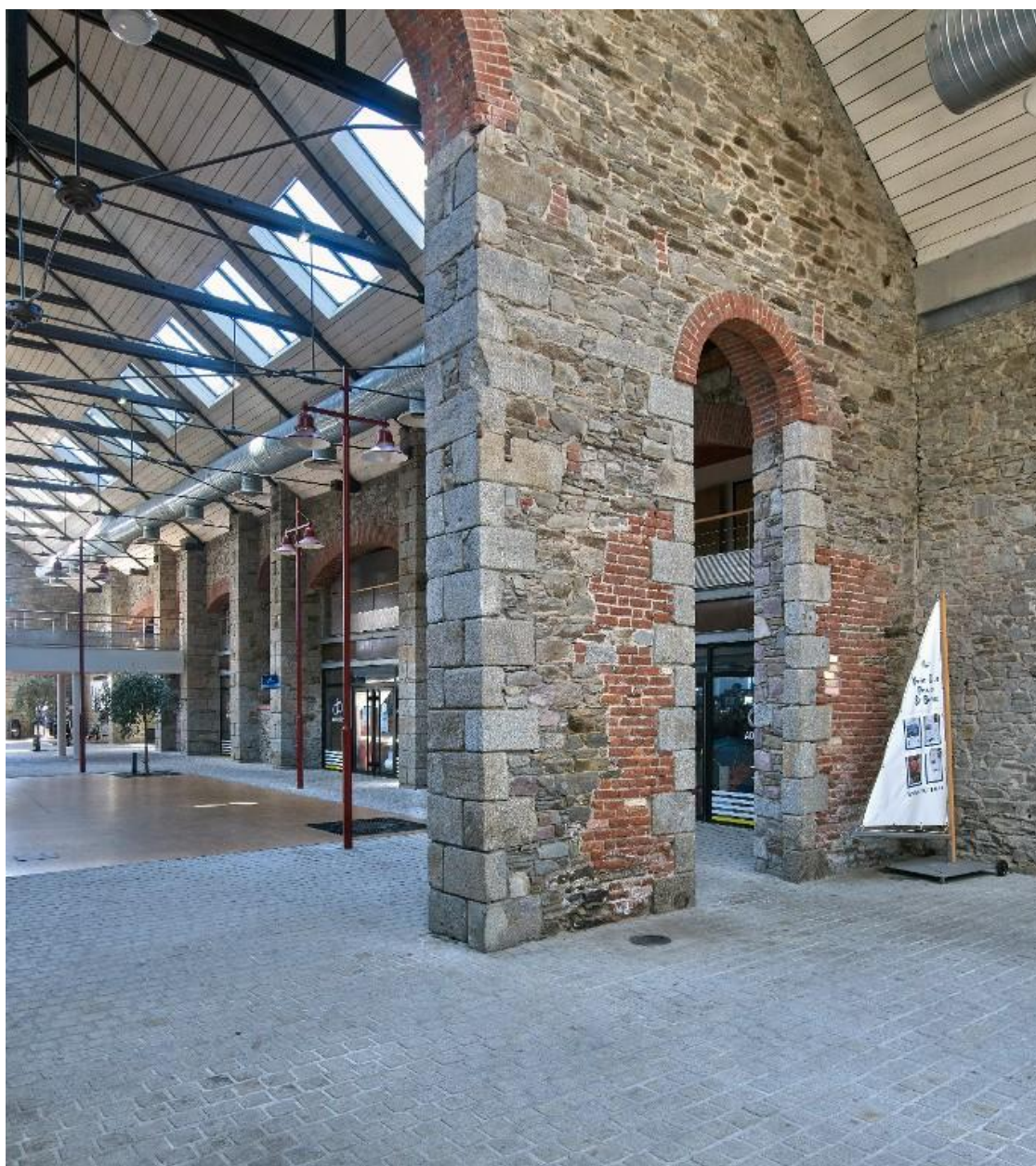
Arche centrale et vestiges du plan de circulation de l'ancienne usine : granite et briques
