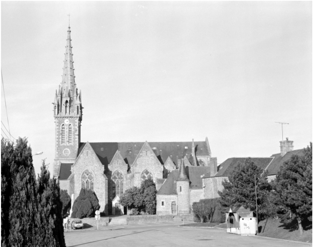
Elévation Sud : vue générale
