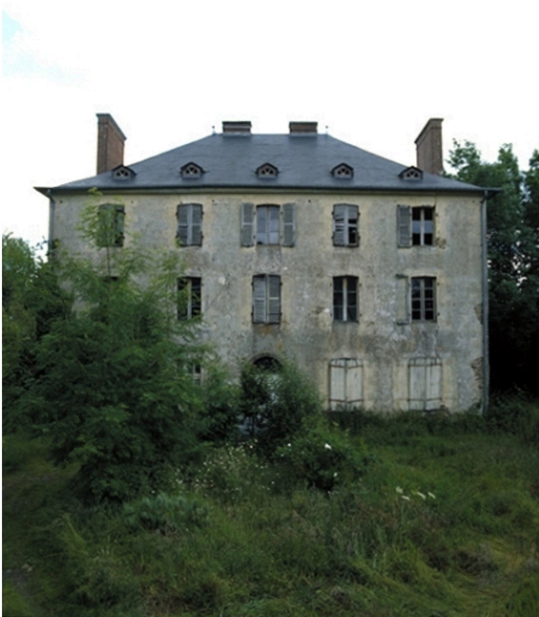
Façade antérieure : vue générale ouest
