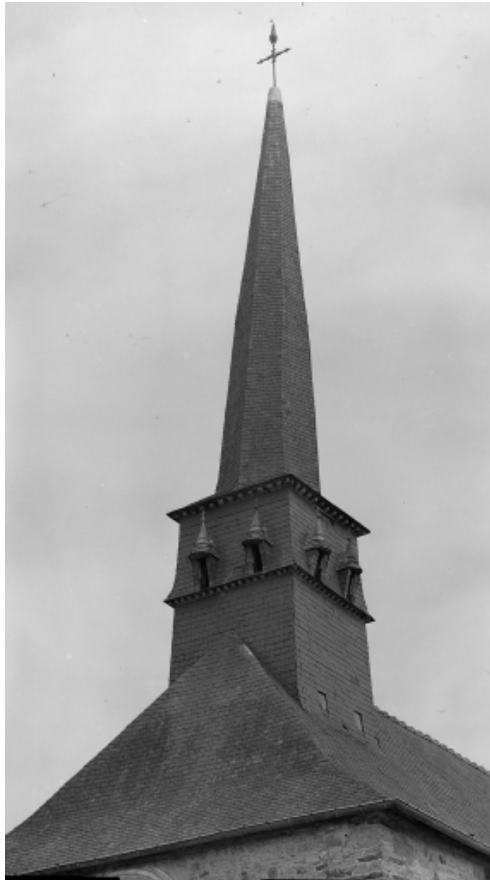
Flèche de charpente, vue de détail.
