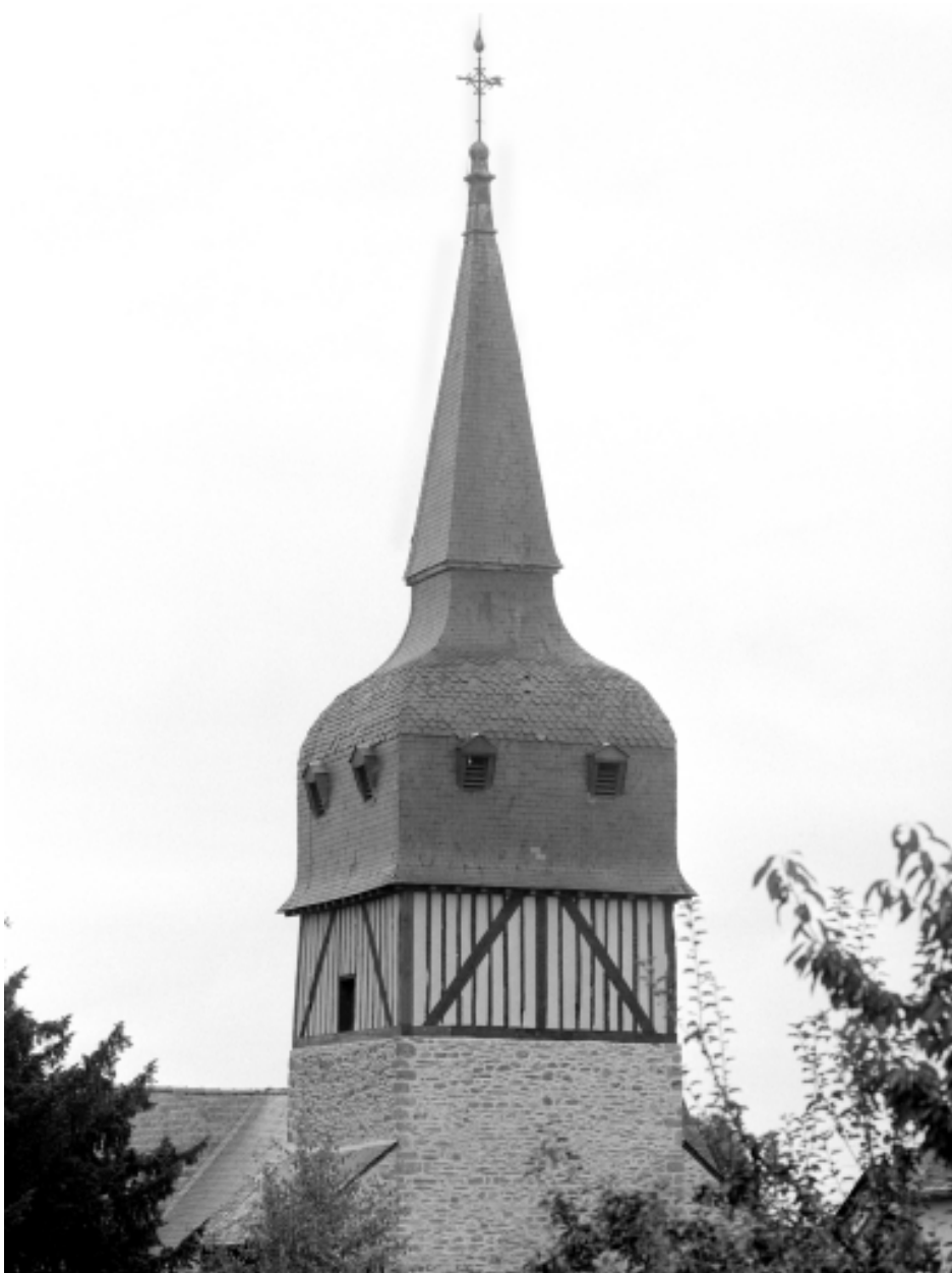
Elévation ouest : partie haute du clocher
