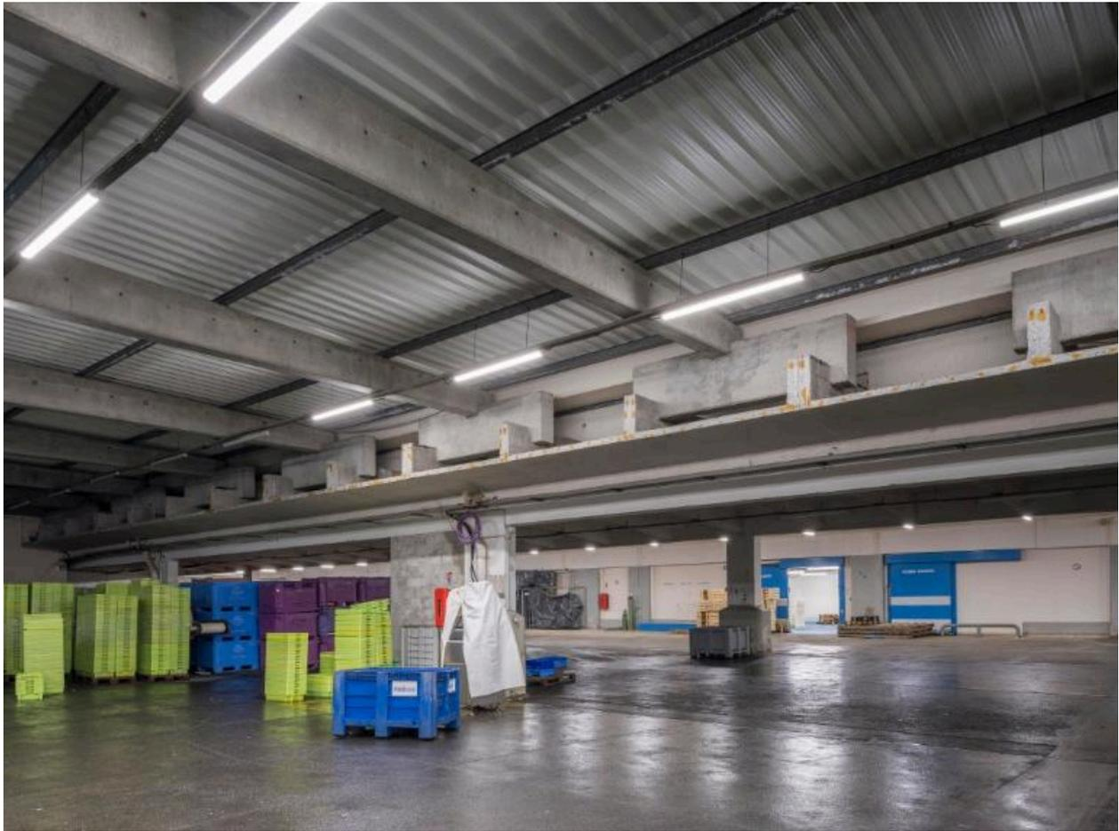
Jonction entre le bâtiment des années 1950 et celui de 1990 : poutres béton sectionnées
