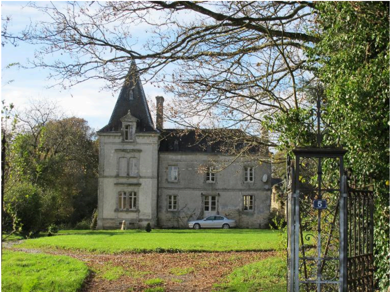
Logis, élévation antérieure est, état en 2015
