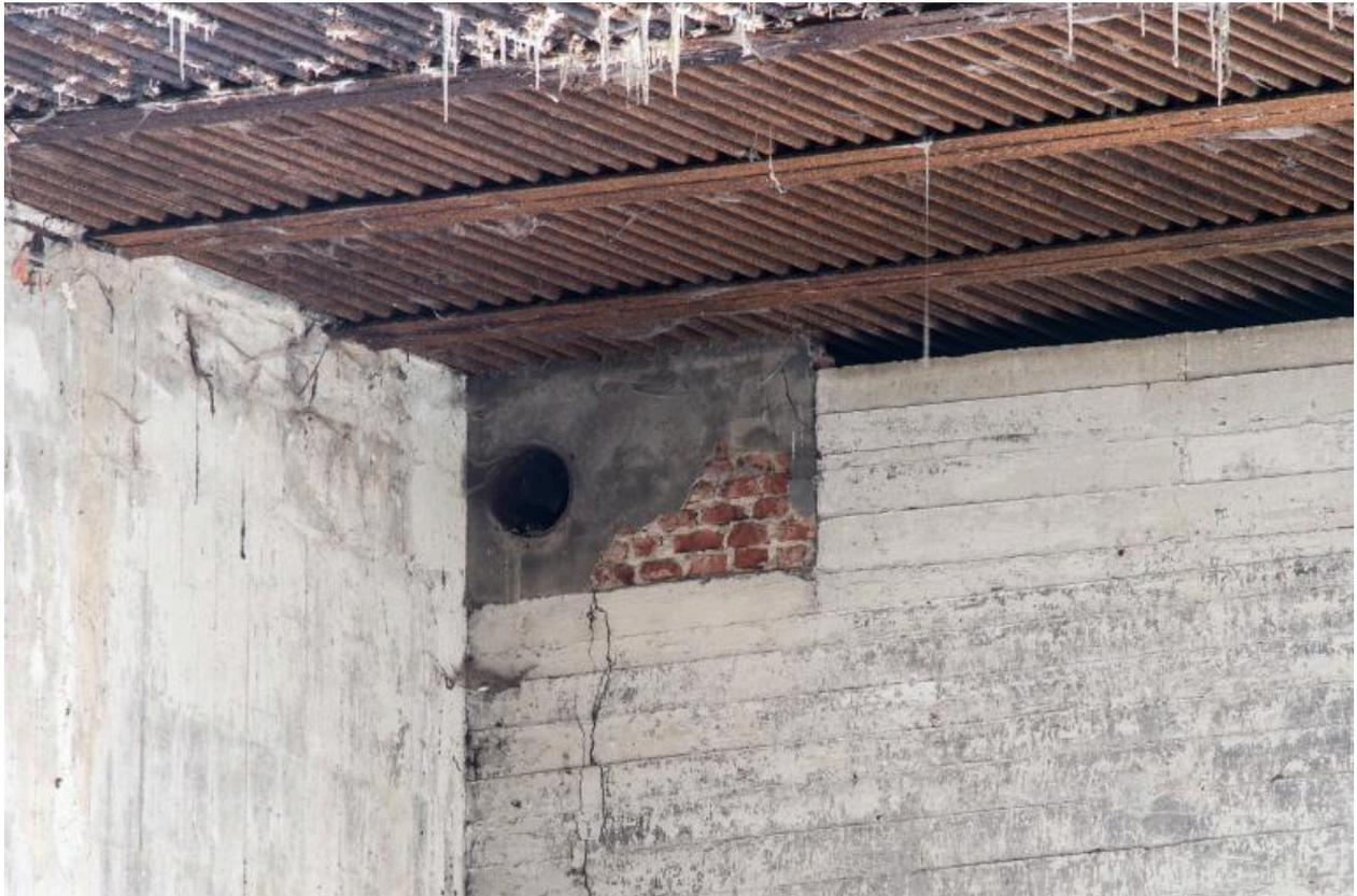
Vue d'un tuyau aménagé dans un angle au niveau du plafond. On aperçoit le remplissage en brique
