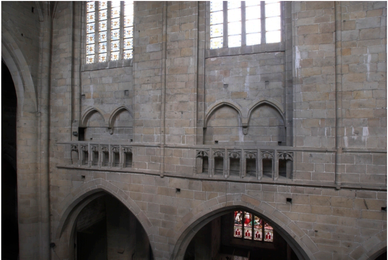
Vue du triforium du choeur
