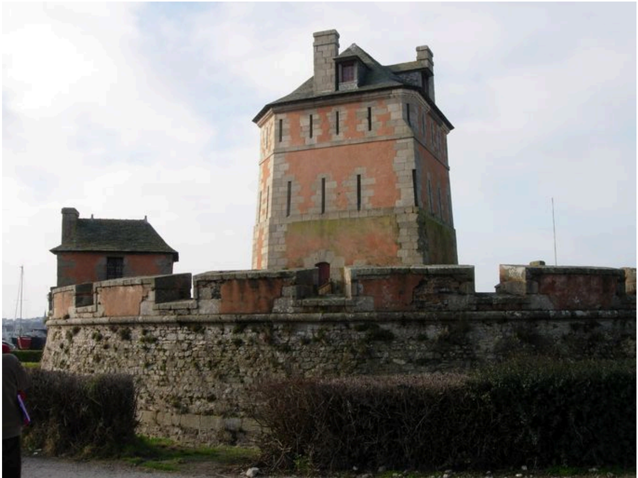
Tour, batterie et corps de garde
