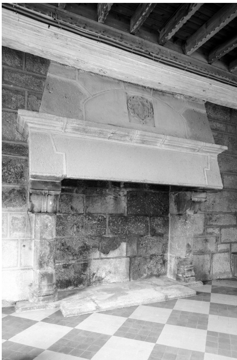
Corps de bâtiment ancien, rez-de-chaussée, pièce sud ouest, mur sud : cheminée
