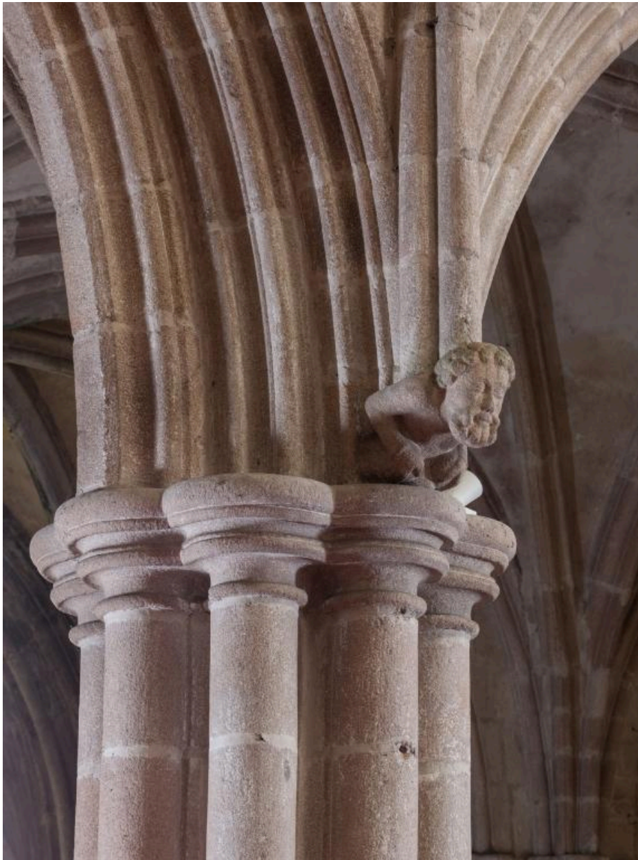
Détail de l'un des piliers orné d'une tête humaine
