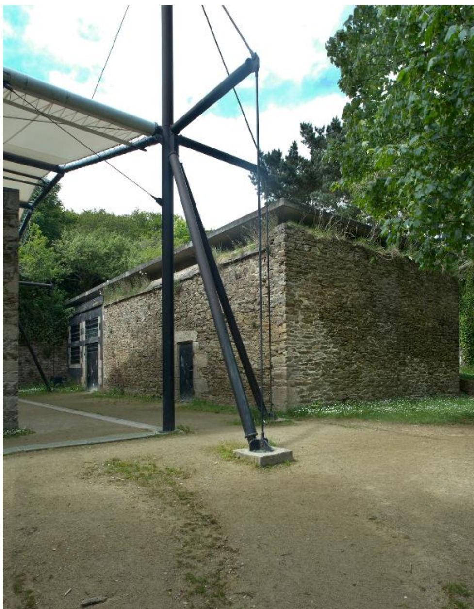
Plouzané : vue du fort du Dellec
