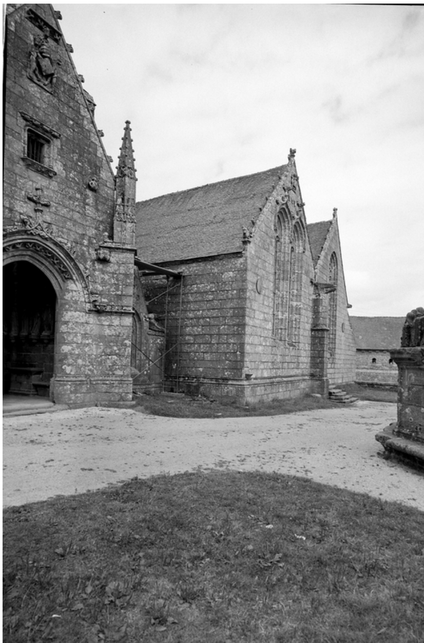
Façade sud, croisillons sud : vue prise du sud ouest
