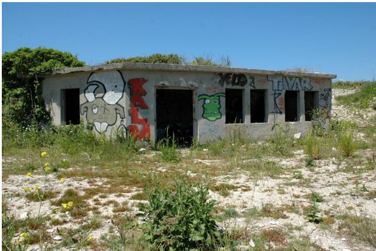
Vue de la cuisine et cantine en béton armé (état en 2005)
