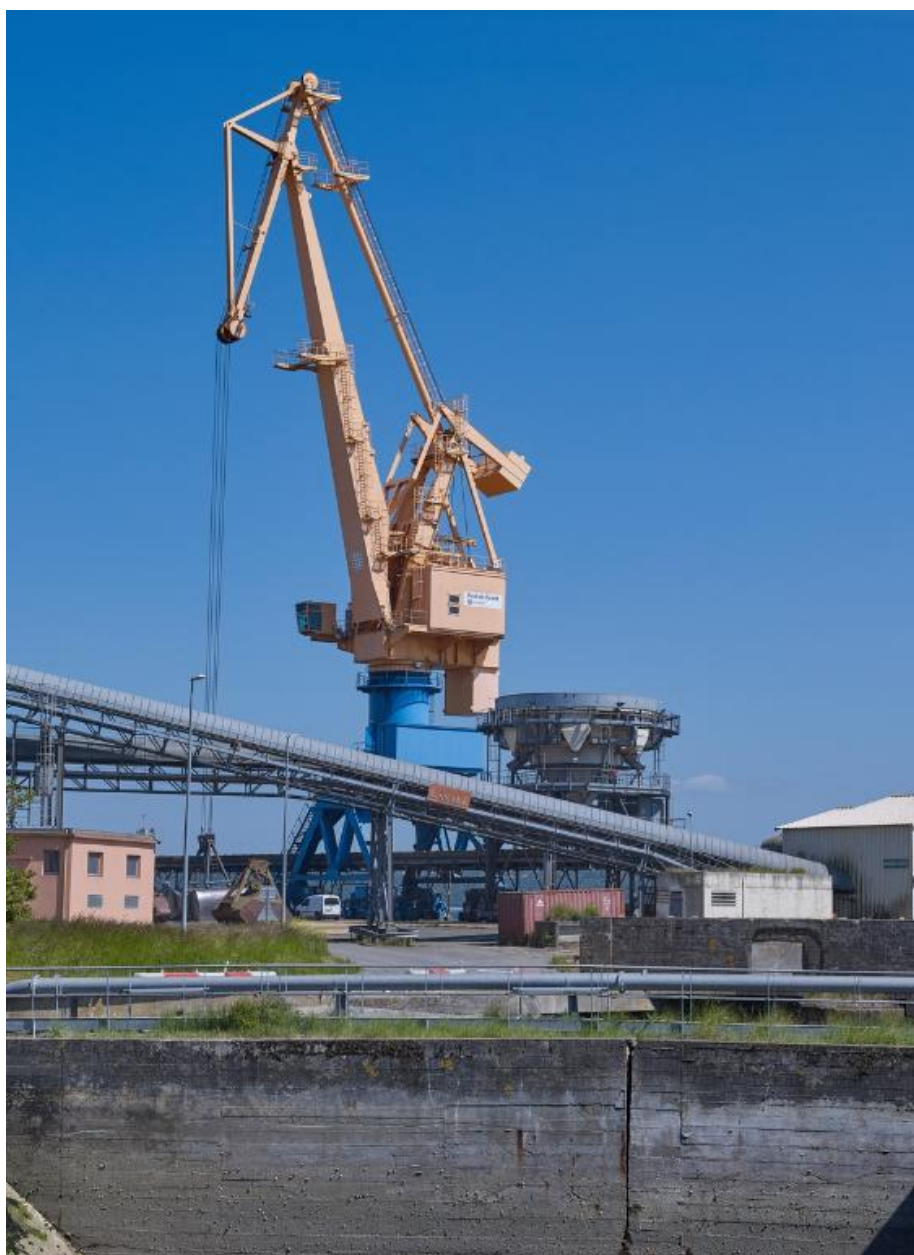
Bandes transporteuses, trémies et grues du 6e bassin
