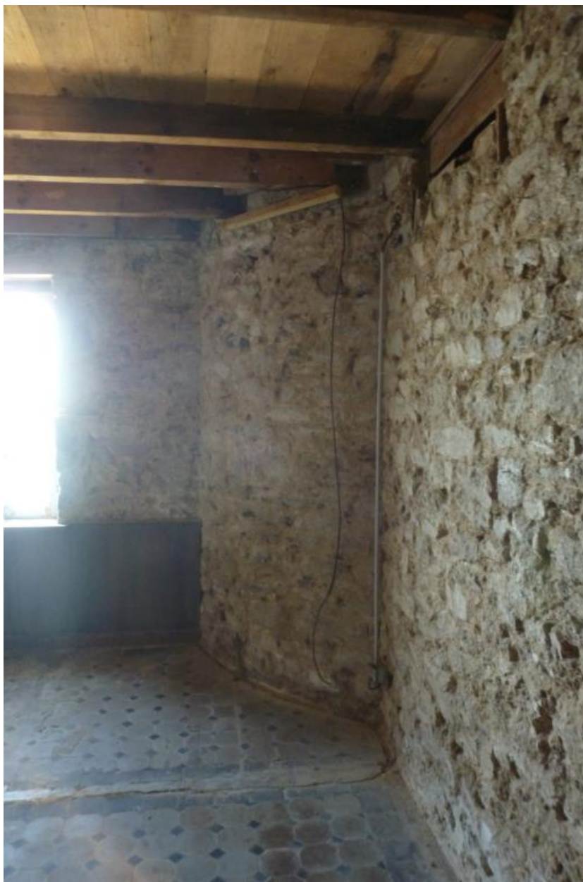
Cuisine, tour encastrée dans l'angle nord-est.
