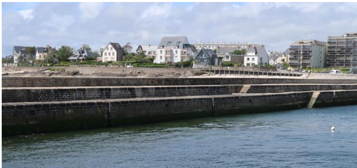
Môle de la Croix, escaliers et plusieurs paliers de niveaux différents
