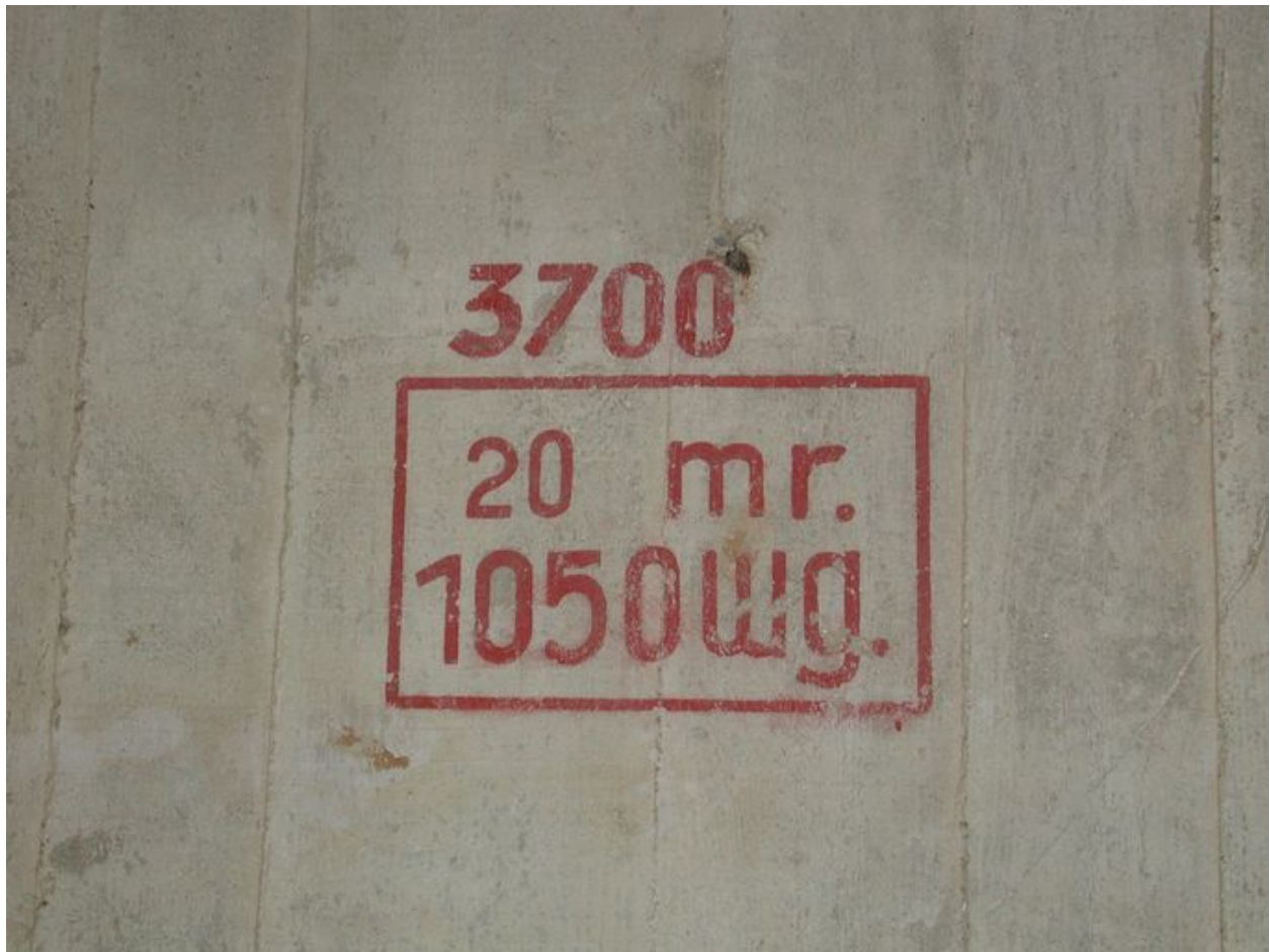
Vue de l'un des marquages présents dans chaque casemate (état en 2002)
