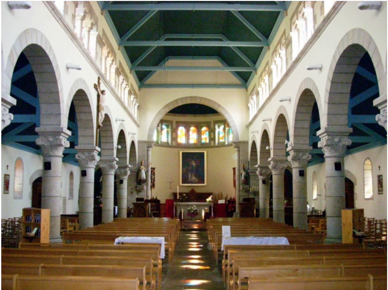
Plomelin, église paroissiale : vue axiale est
