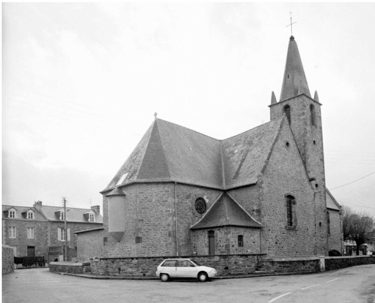
Elévation Nord-Est : vue générale
