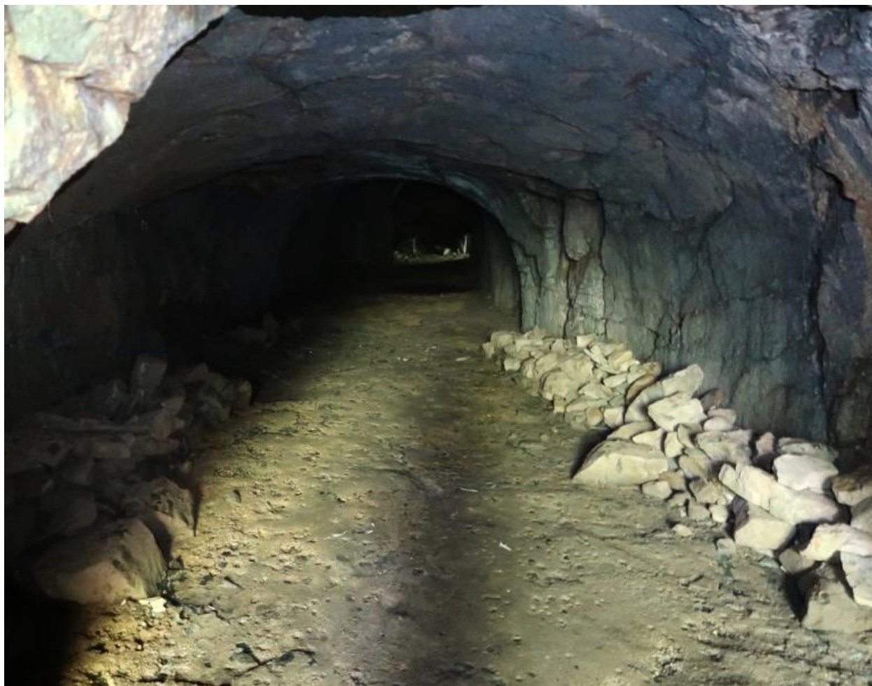
Vue du souterrain creusé dans le massif rocheux
