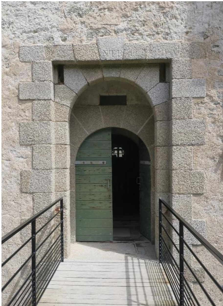
Sauzon, pointe des Poulains, corps de garde crénelé dit Fort Sarah Bernhardt, porte.
